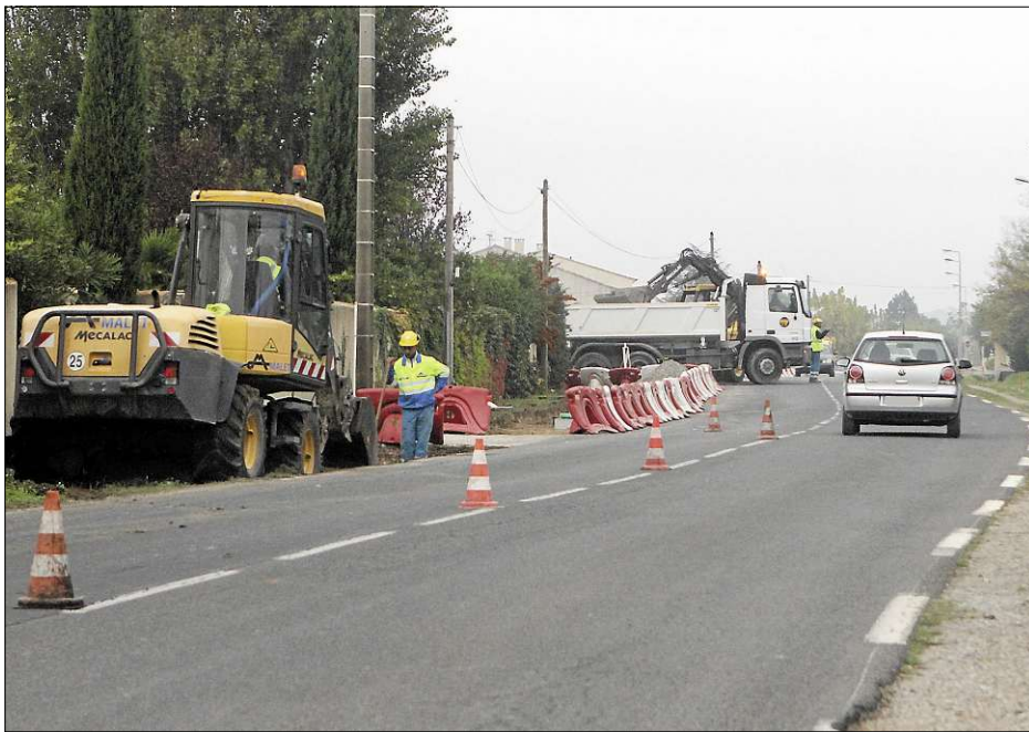
■ Trois mois de travaux route de Vendargues pour améliorer la sécurité.
