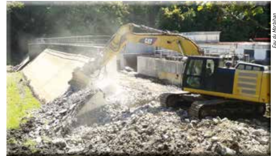
À la mi-août, les premiers coups de pelle ont attaqué le barrage.
